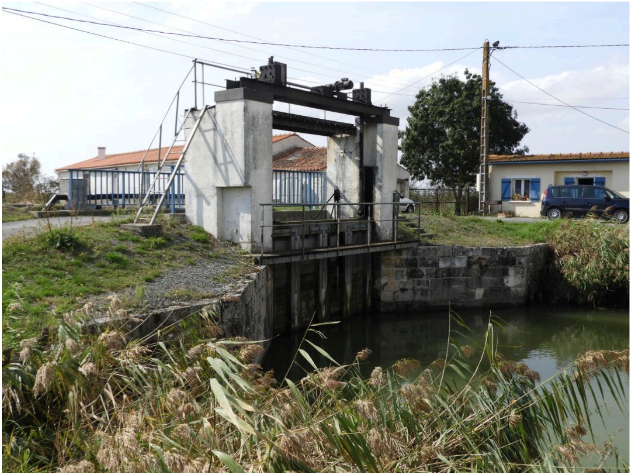
La porte vue côté amont, depuis le nord-est.
