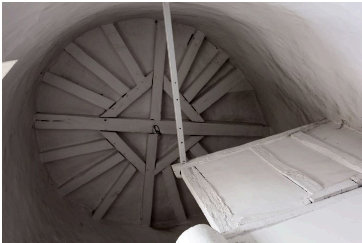
Couvrement de la tourelle d'escalier.
