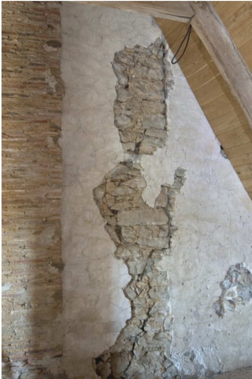
Intérieur du logis, comble : Détail du mur-pignon sud (partie droite).
