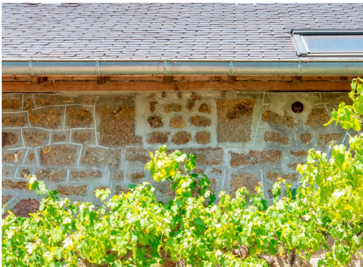
Façade sud, vestiges de lucarne (bâtiment 1).
