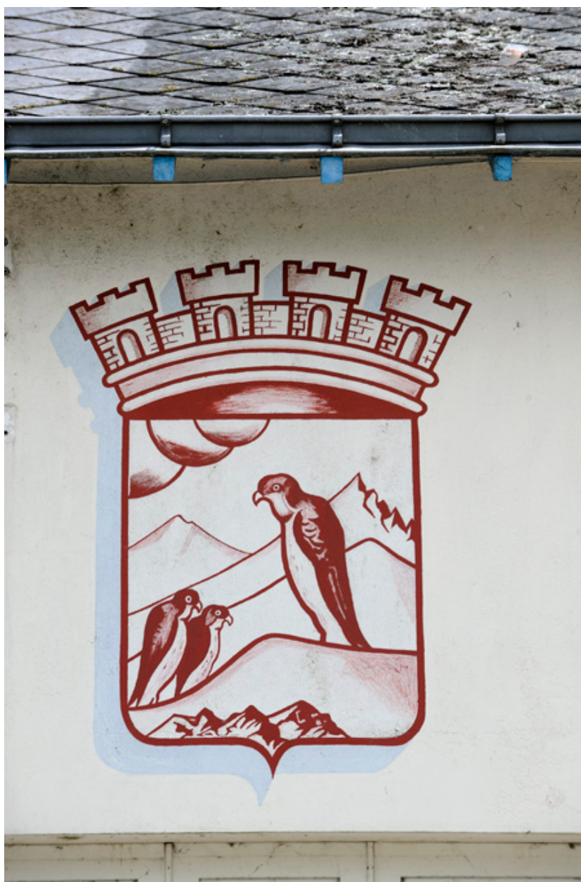
Laiterie-fromagerie Gallais : détail de la façade est.
