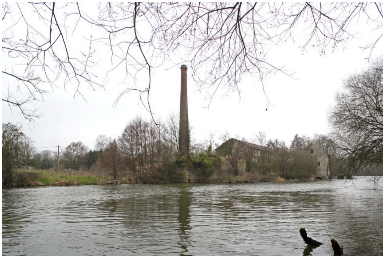
Vue d'ensemble du site du moulin à farine et de la filature depuis la rive gauche en aval.
