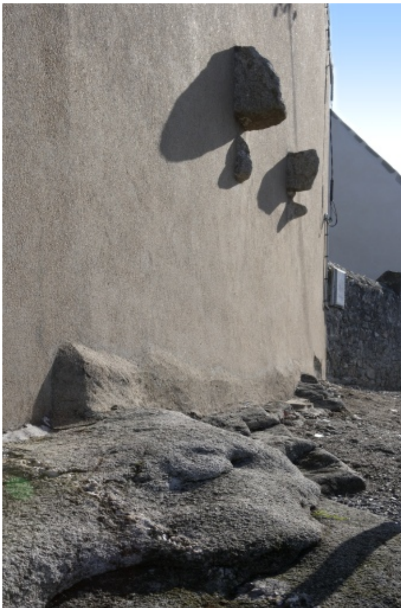
Détail de l'affleurement rocheux sur le pignon sud du 1er logement.
