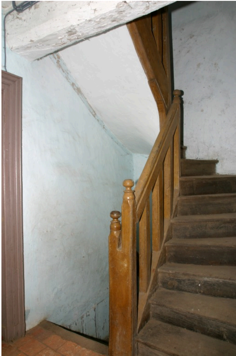
Le corps central, rez-de-chaussée : l'escalier.
