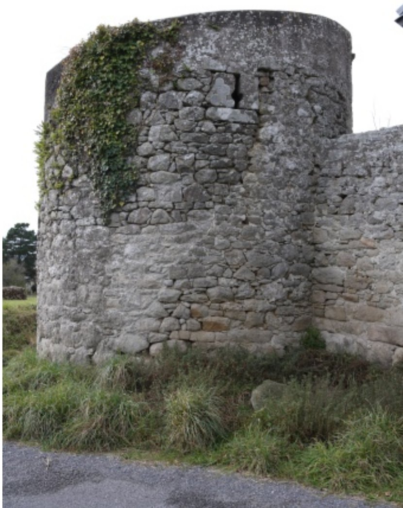
Mur de clôture. Tour d'angle sud-est.
