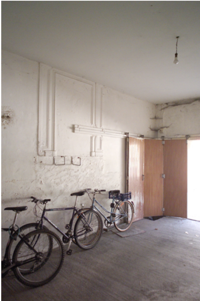
La pièce située au nord, détail du trumeau de la cheminée.
