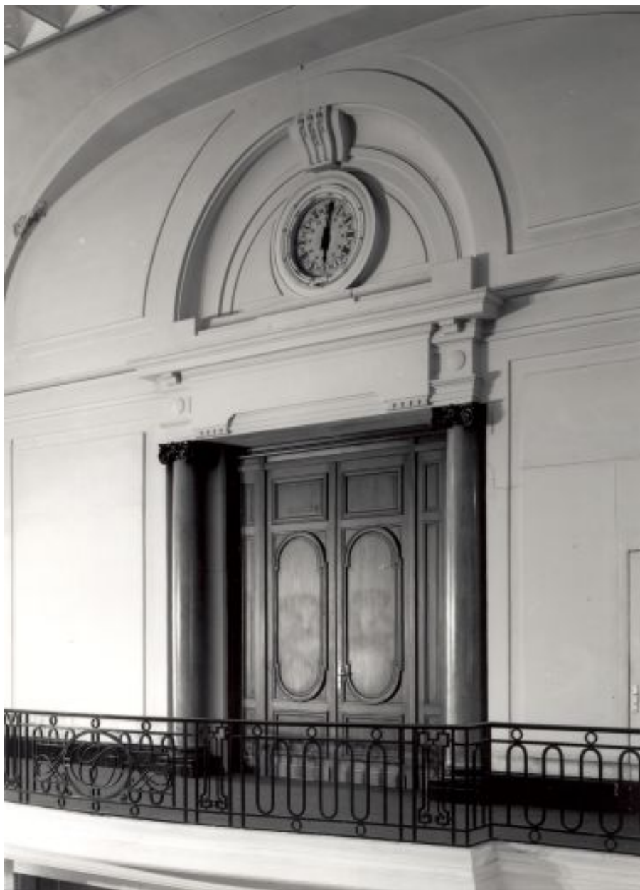
Le hall, élévation latérale gauche, premier étage : la porte de la salle du Conseil.
