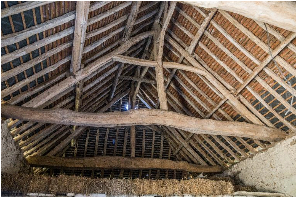
Grange-étable : détail de la charpente.
