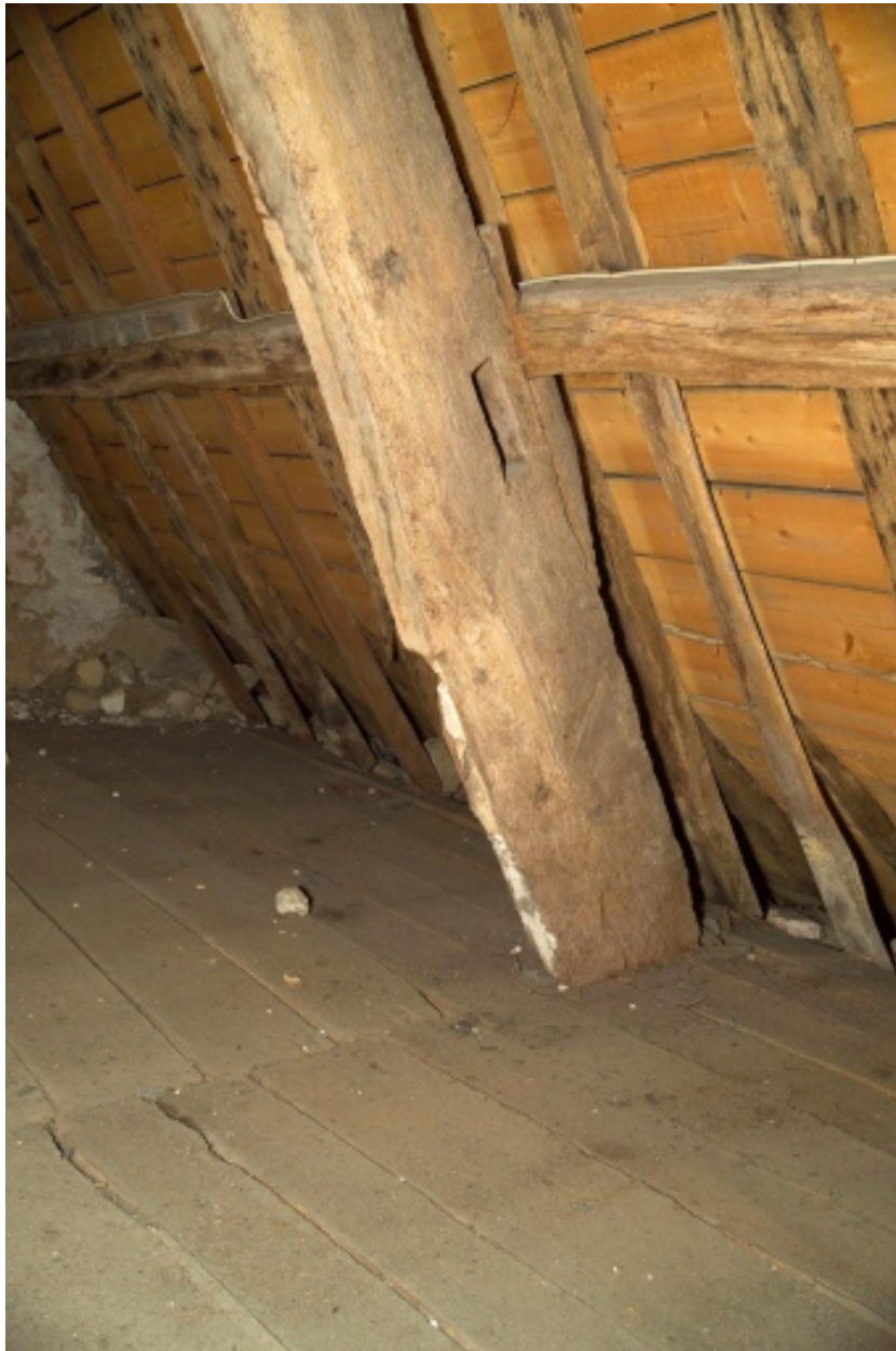
détail d'un arbalétrier de charpente, mortaise de jambette.
