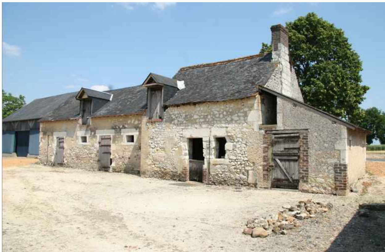
Maison 6 : vue d'ensemble.
