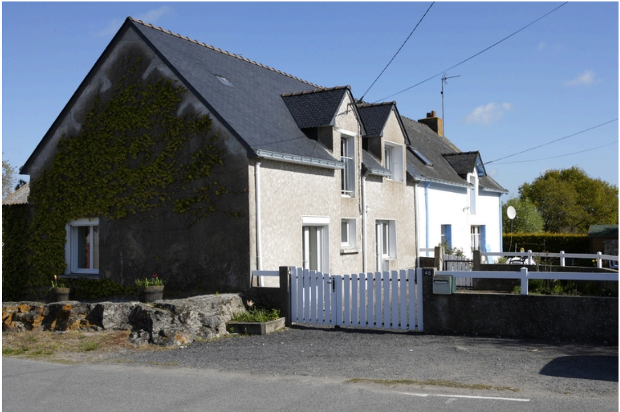
Vue d'ensemble de la rangée.
