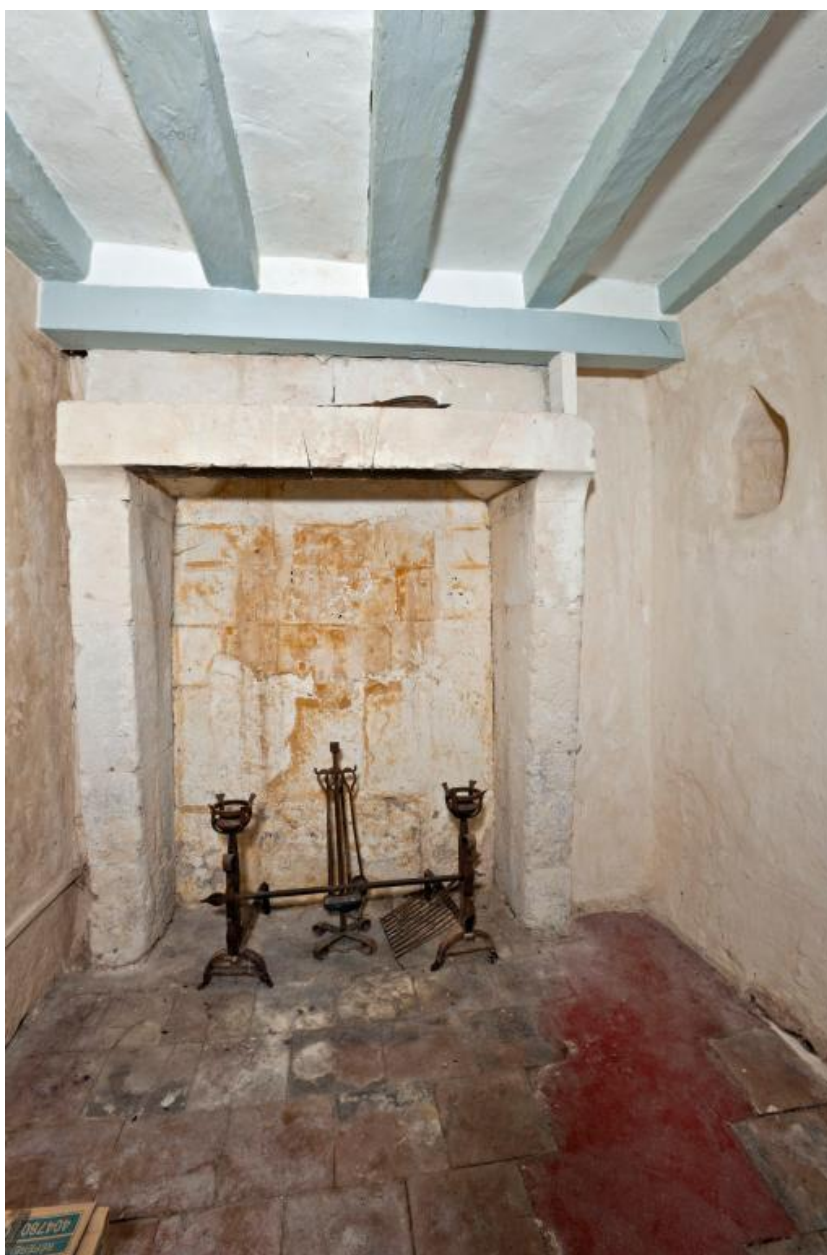
Atelier, intérieur : cheminée.
