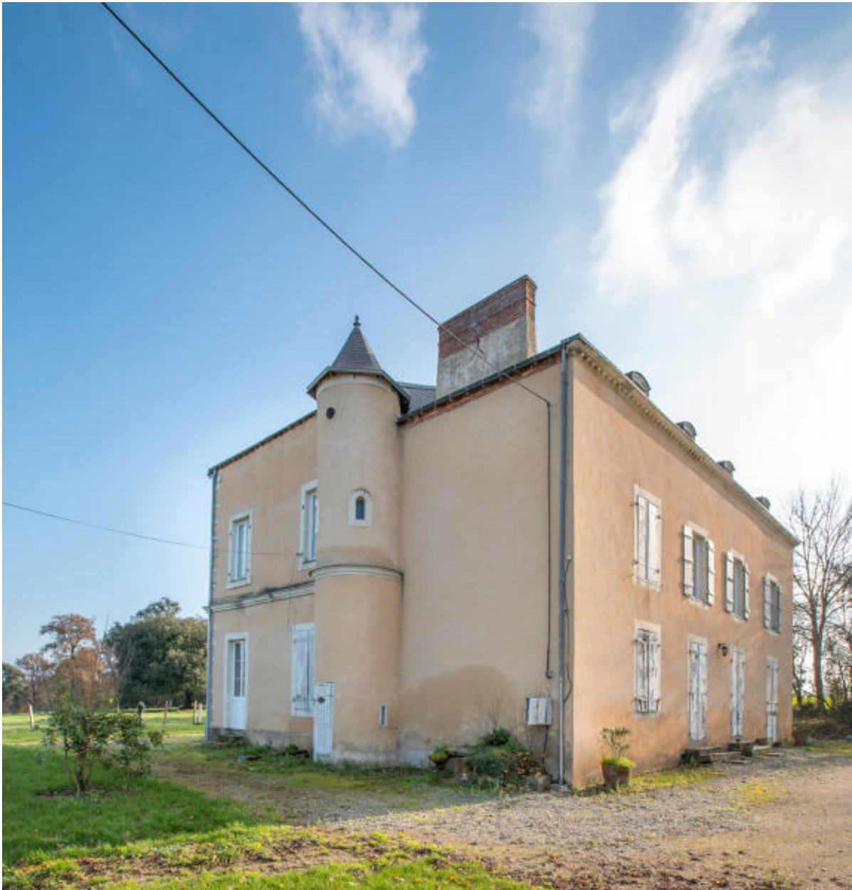
L'élévation latérale nord de la demeure.
