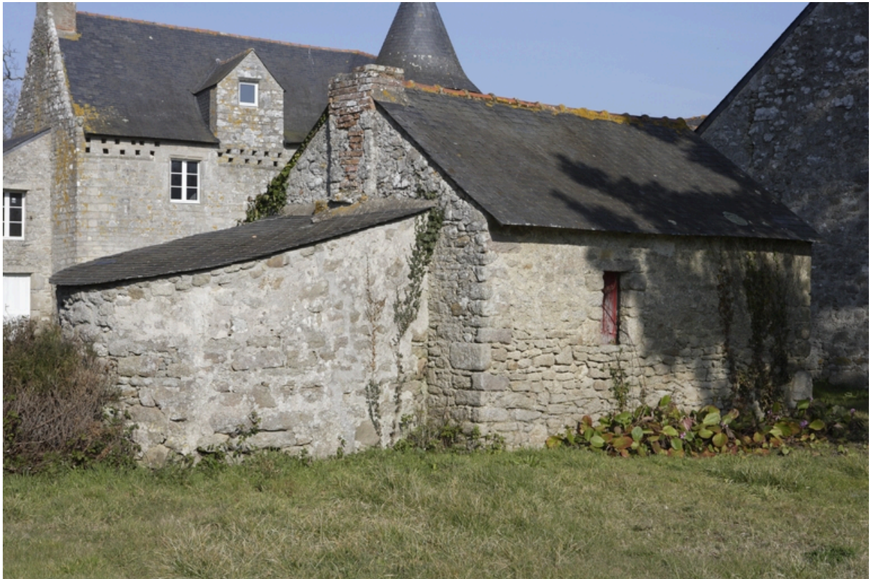
Vue du fournil depuis le sud.
