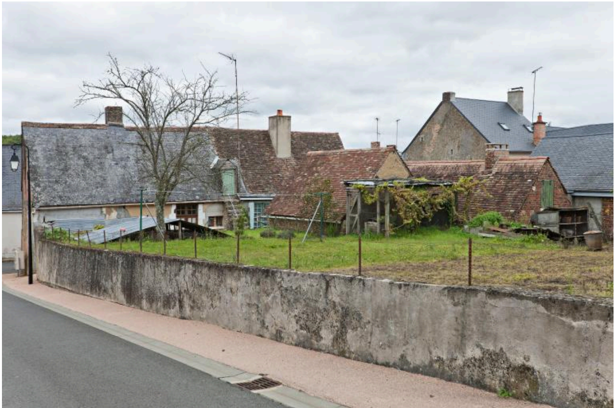
Vue d'ensemble prise depuis le sud.
