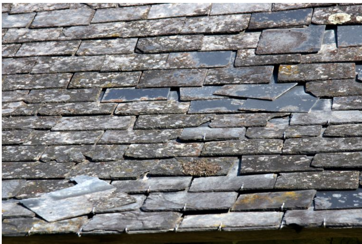
Couverture de la maison : ardoises cloutées.
