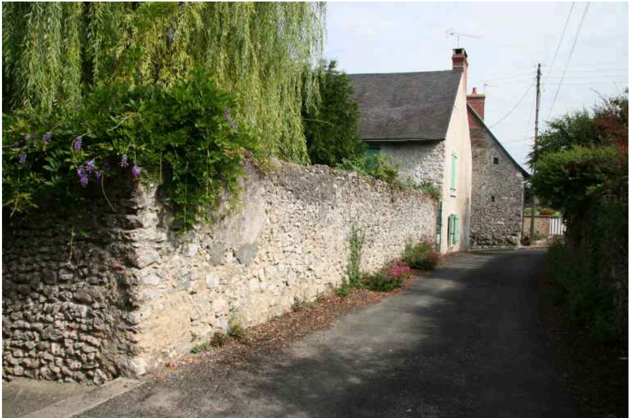
Rue des Lilas, rive ouest mur de clôture.
