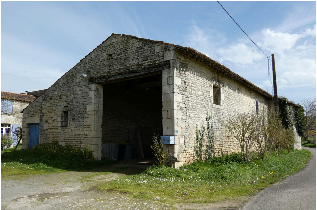
Le hangar au sud de la cour, vu depuis l'ouest.
