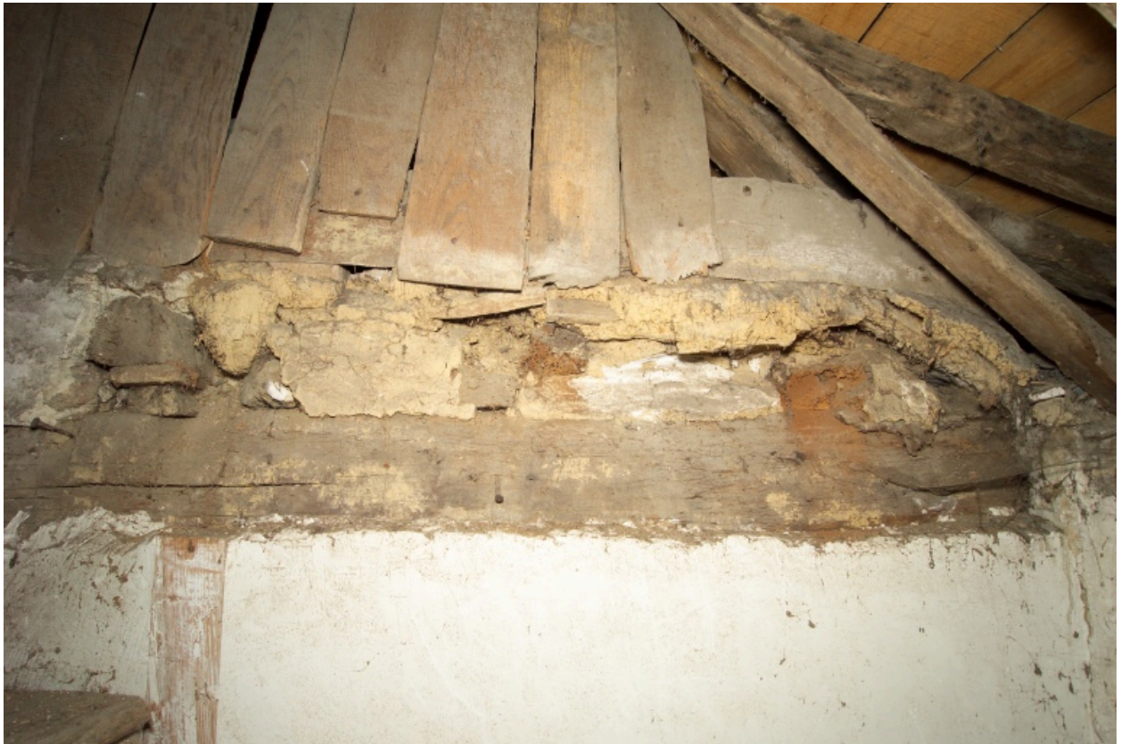
Plancher du comble et cloison de bois vus depuis la cage d'escalier.
