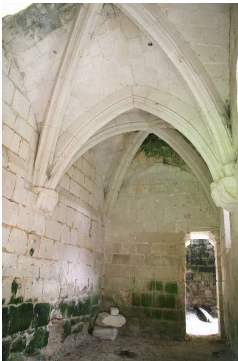
Ancien château, rez-de-chaussée : 1ère salle de deux travées voûtées d'ogives.
