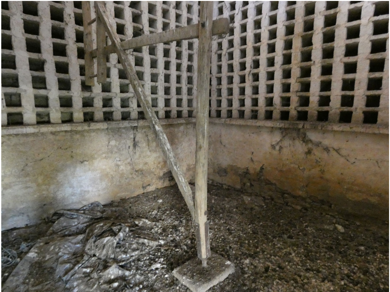
Le soubassement et la base de l'échelle.
