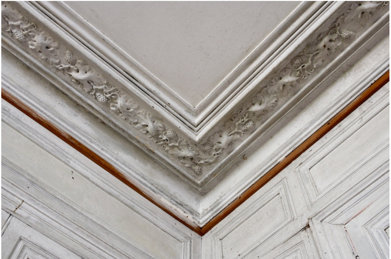
Logis. Détail de la corniche de la salle.
