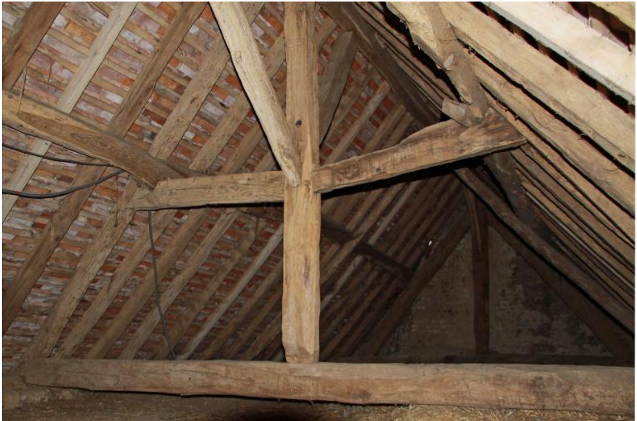
Logement 1 : charpente à pannes à encoches.
