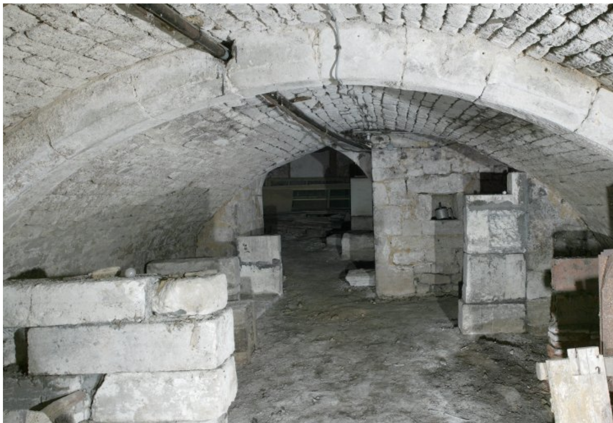
Vue du sous-sol.
