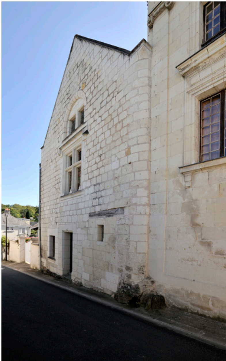
Vue de la liaison entre le corps principal et l'extension du XIXe siècle.
