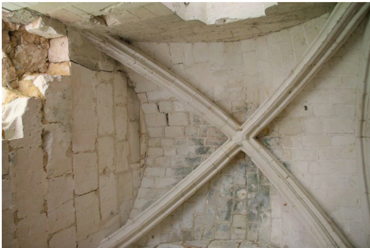
Ancien château, rez-de-chaussée, 1ère salle voûtée : 2e travée.
