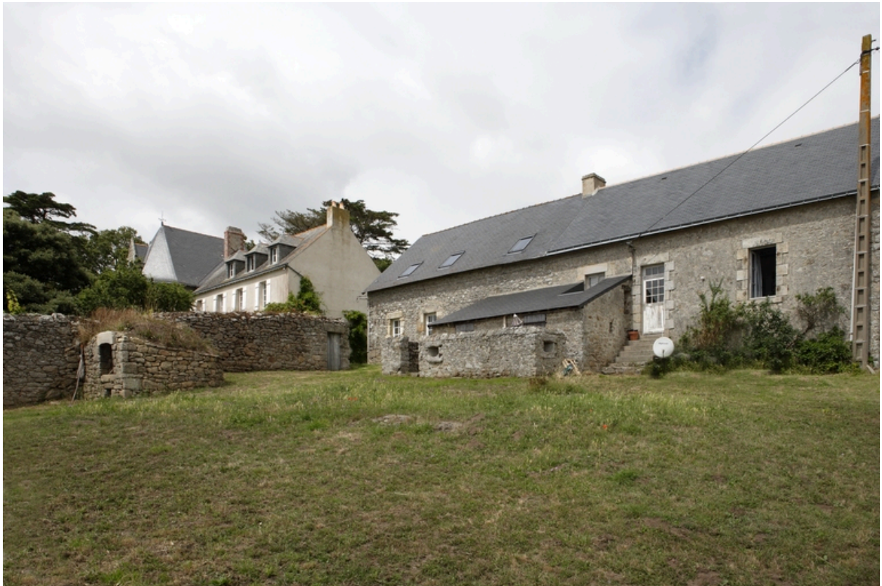
Métairie. Vue d'ensemble depuis le sud-est.
