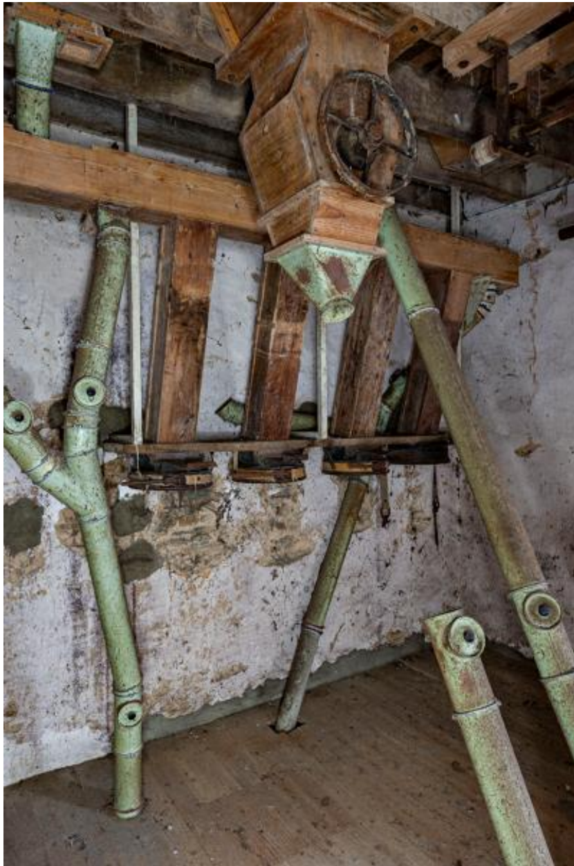
Deuxième étage, partie nord-ouest : les ensacheurs à son vus depuis le sud-est.
