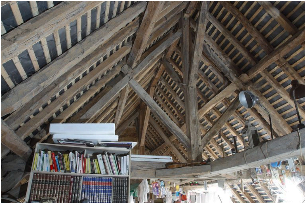
Comble : la ferme centrale de la charpente vue depuis le nord.
