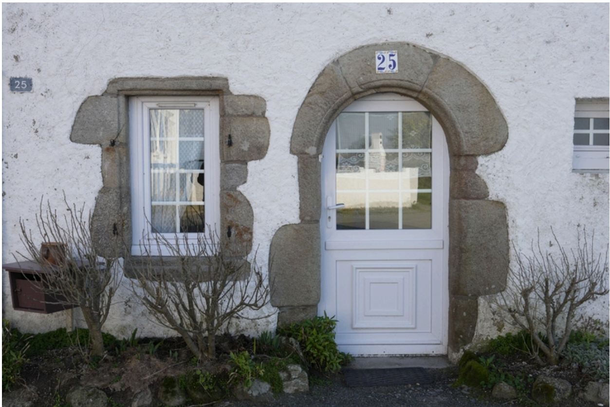
Détail de la porte et de la fenêtre sur la façade est du n° 25.
