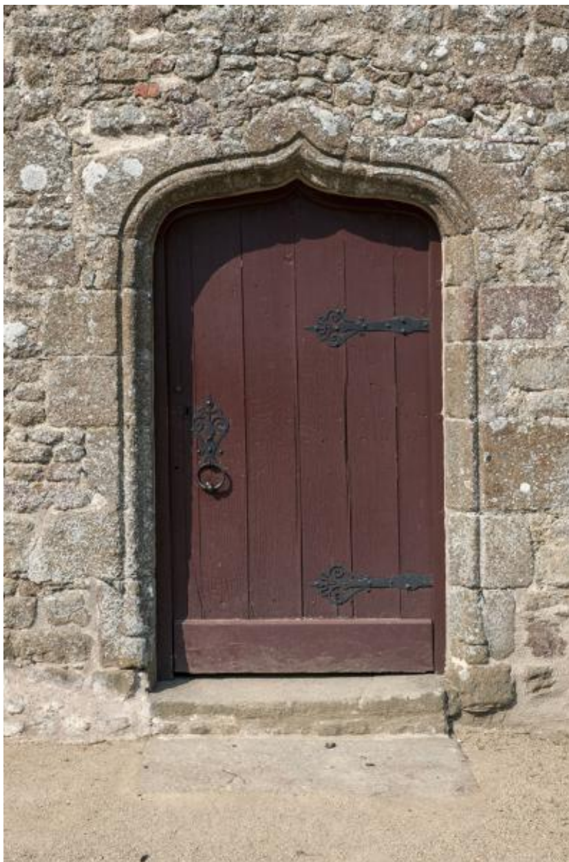
Porte de la tour occidentale du châtelet.
