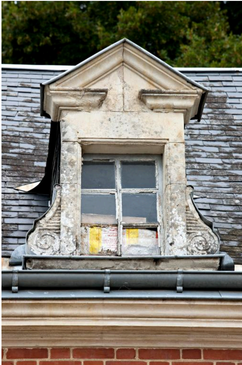
Maison, façade antérieure : lucarne au-dessus de la porte d'entrée.
