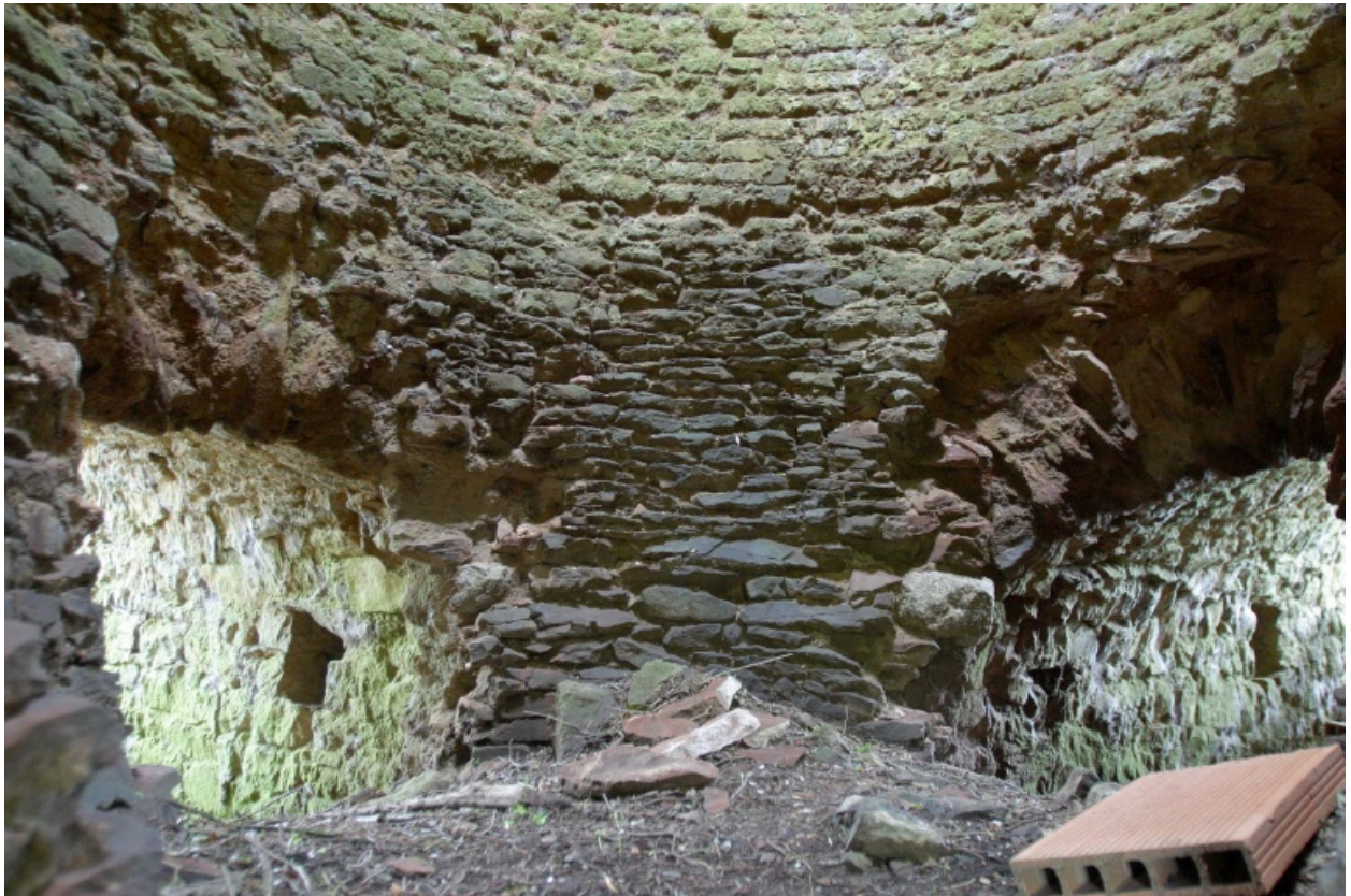
Vue intérieure du premier four : la partie inférieure ou foyer.
