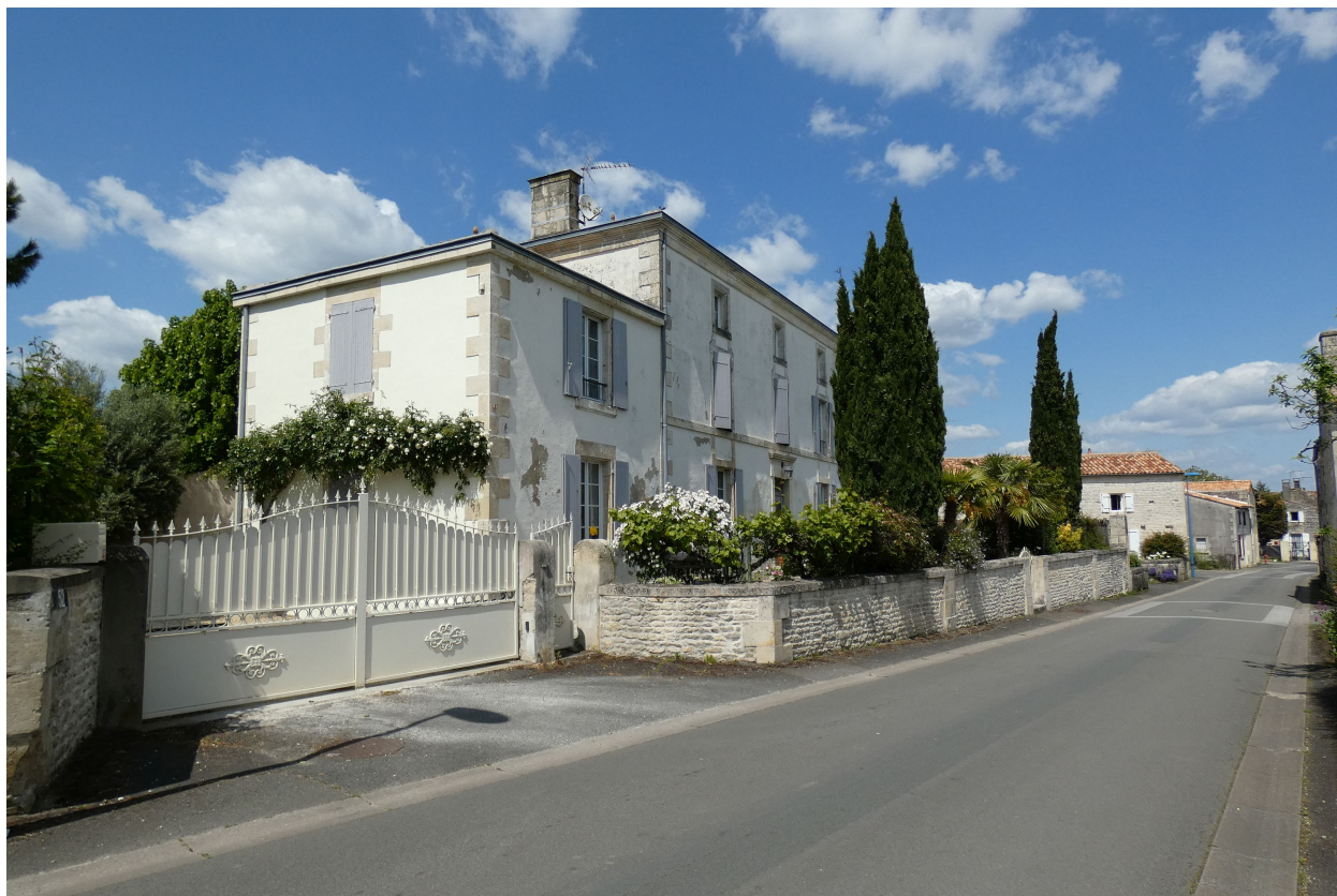
Le logis vu depuis le sud.
