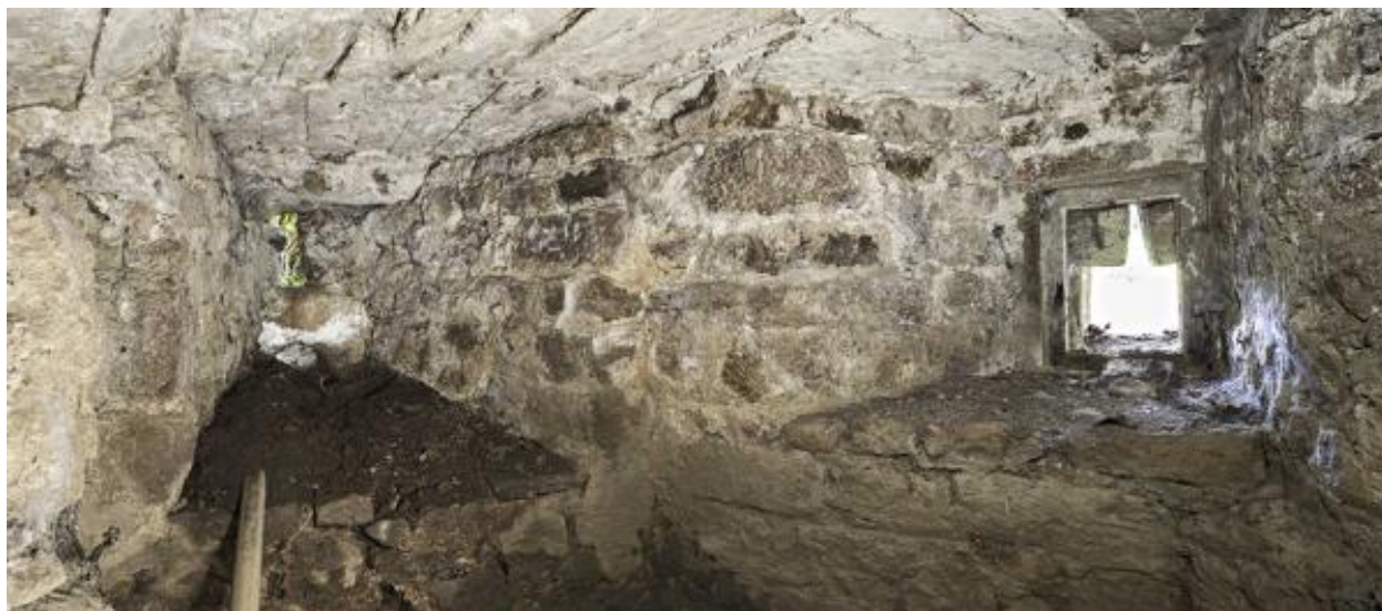
Casemate ouest dans le soubassement de la tour nord, ouverte de deux bouches à feu.
