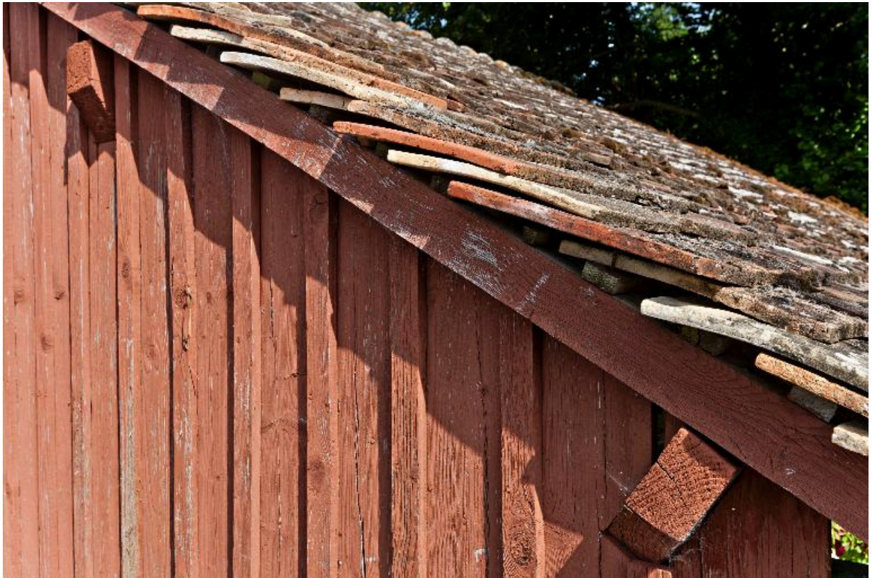
Détail de l'essentage de planches du pignon gauche.
