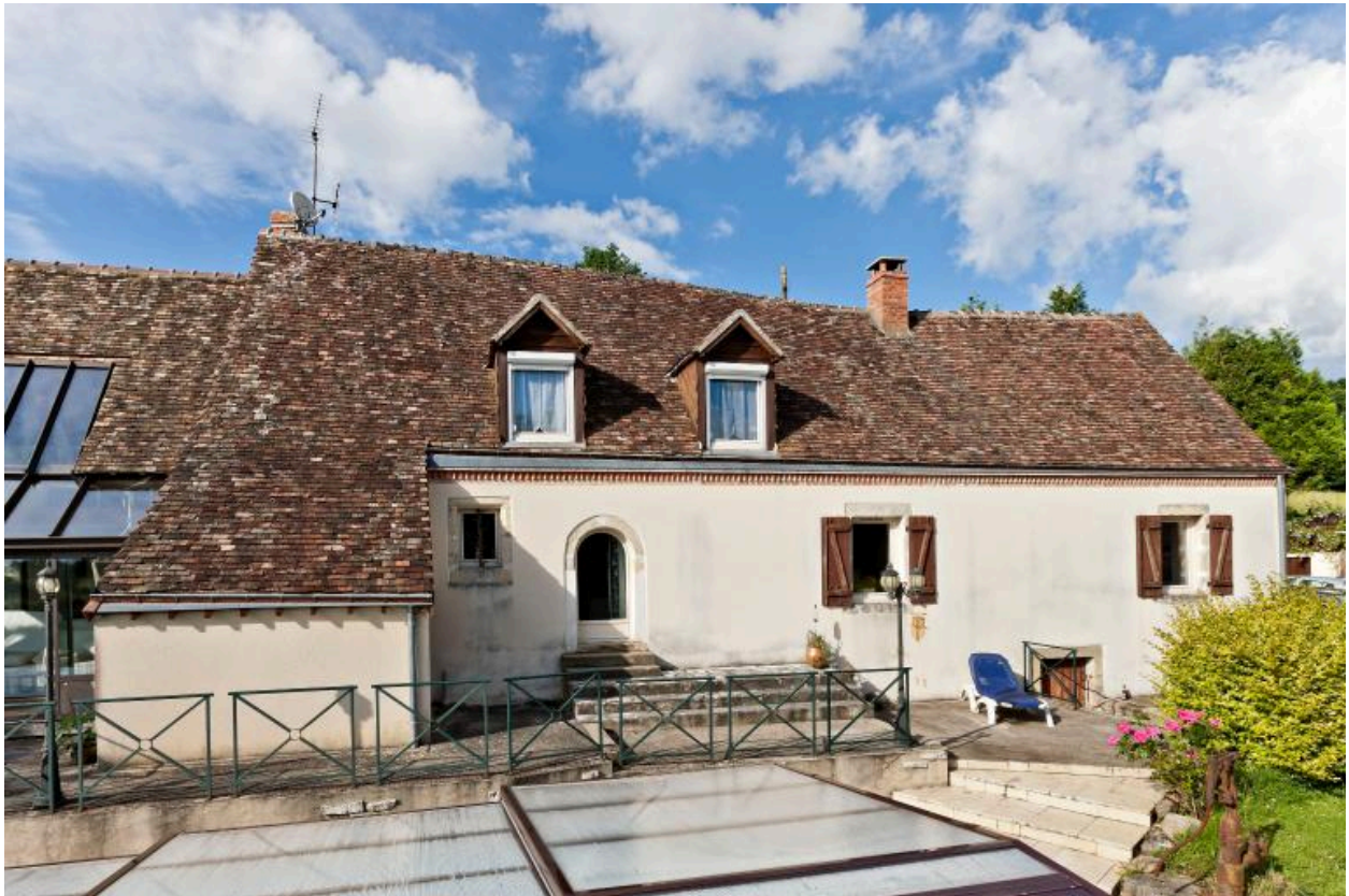
La Porte, ferme, actuellement maison. Elévation sur cour du logis.
