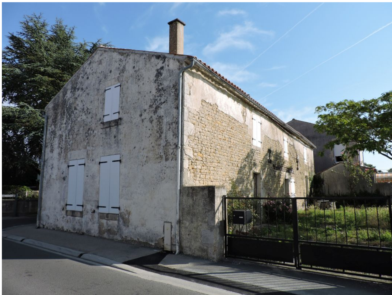
L'ancien logement de fermier, reconstruit en 1842, vu depuis le sud.
