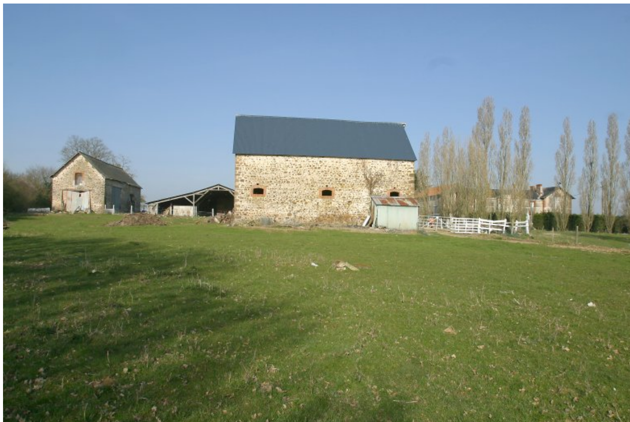
Vue d'ensemble depuis l'est : remise, étable-grange, logis-écurie.
