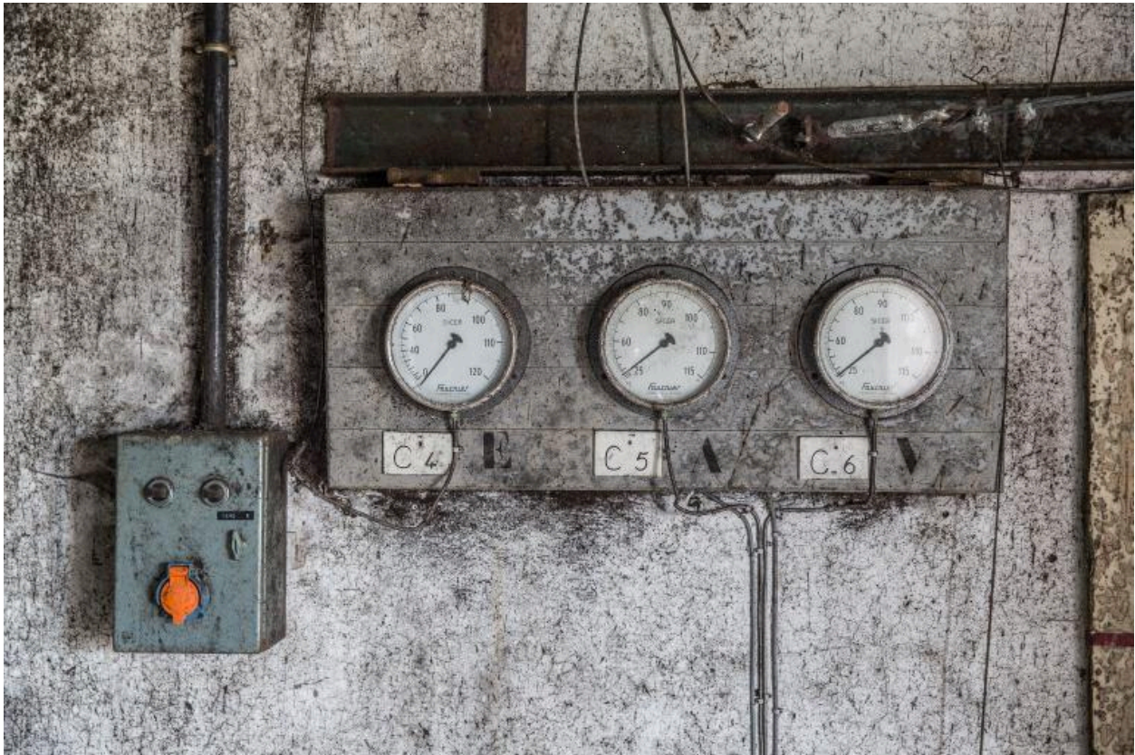
Chai sud, détail : thermomètre des cuves, 2018.
