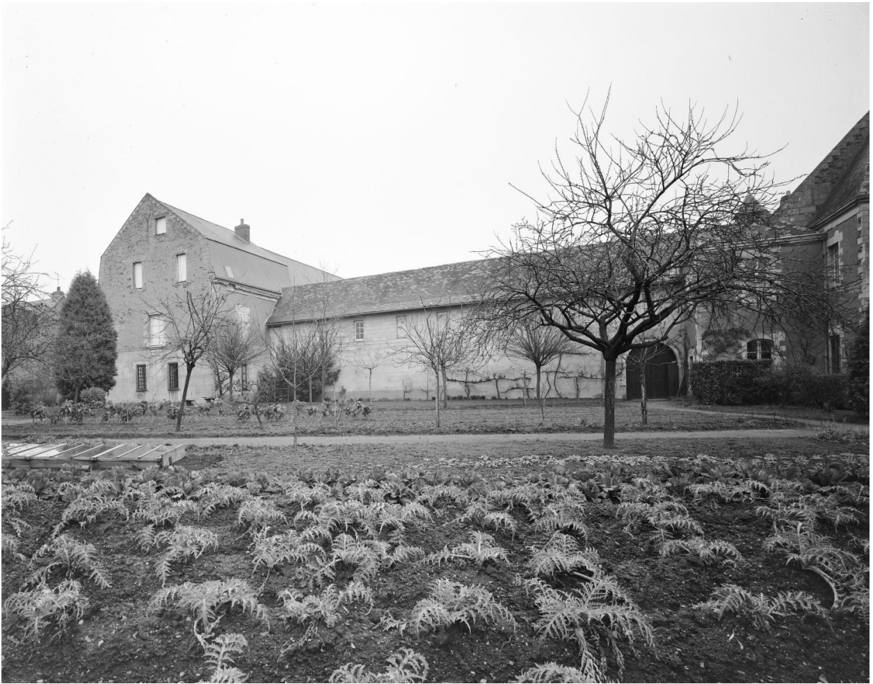
Aile ouest du cloître : façade postérieure (ouest), sur jardin.
