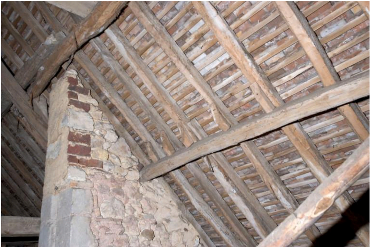
Le pavillon, comble, détail de la charpente, 2007.
