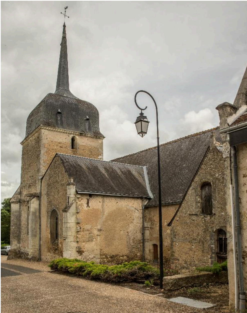
Vue générale prise depuis le sud-est.
