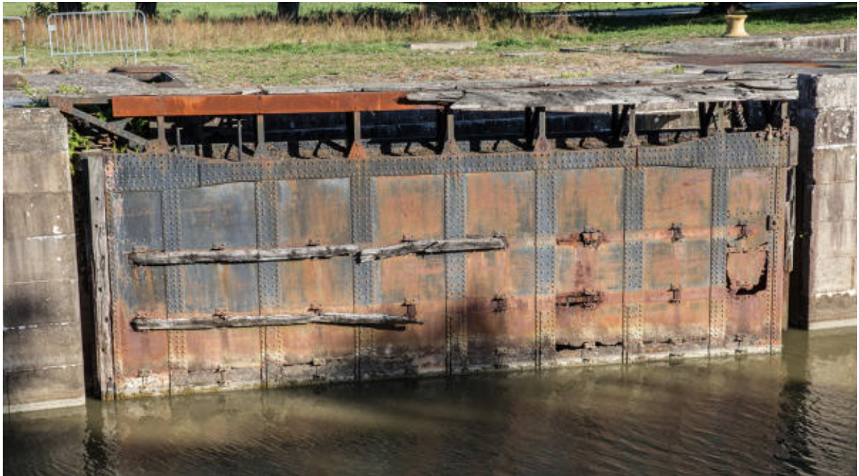
Vue de détail d'une porte de la tête aval de l'écluse.
