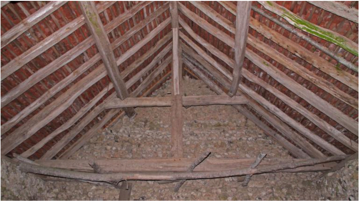
Hangar : charpente à pannes à encoches avec faux-entrait.
