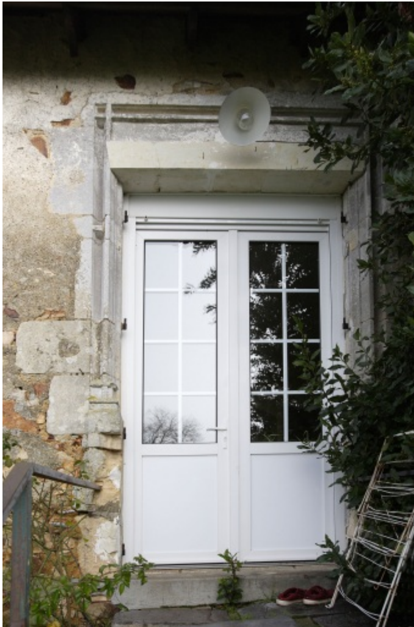
Le logis, corps principal, façade sud, 2e niveau : ancienne fenêtre droite.
